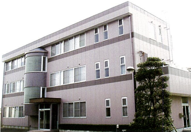
オフィスビル新築工事
