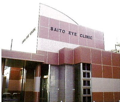
医院新築工事
