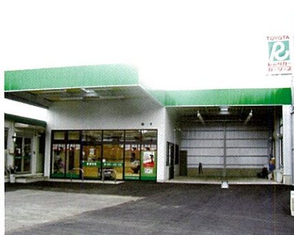
店舗新築工事
